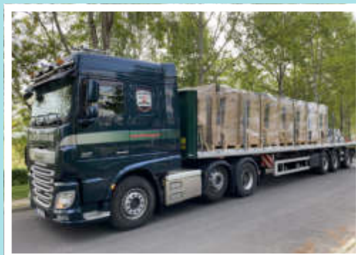
Schweres Gerät am Espencampus: Die neuen Solarmodule werden geliefert.
